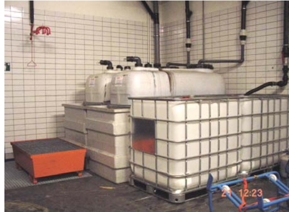
Opslag van de afvoer van de natte chemie.
