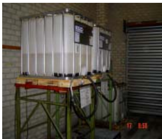
Opslag- en tapruimte gevaarlijke hulpstoffen volgens de PGS15 (voorheen de CPR 15-1)
