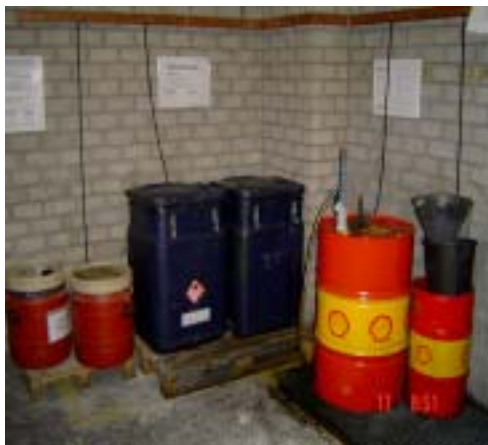
Opslag- en tapruimte gevaarlijke hulpstoffen volgens de PGS15 (voorheen de CPR 15-1)
